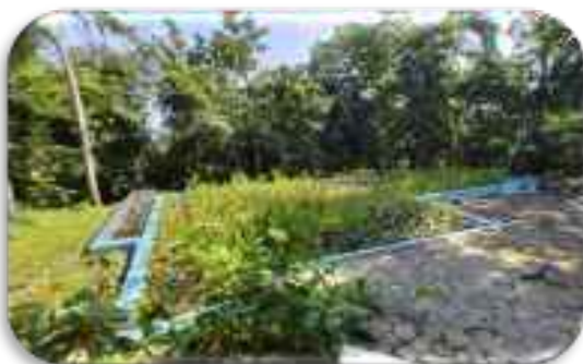
Instalasi Pengolahan Air Limbah
