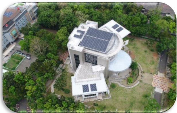
Solar Panel (Rumah Ilmu)
